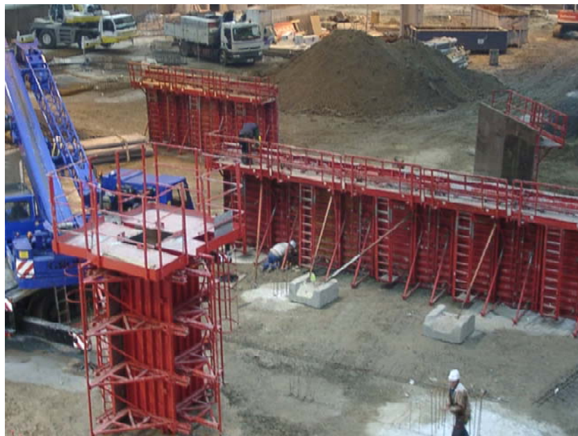
Réhabilitation du hall Rhénus, Strasbourg 2002
